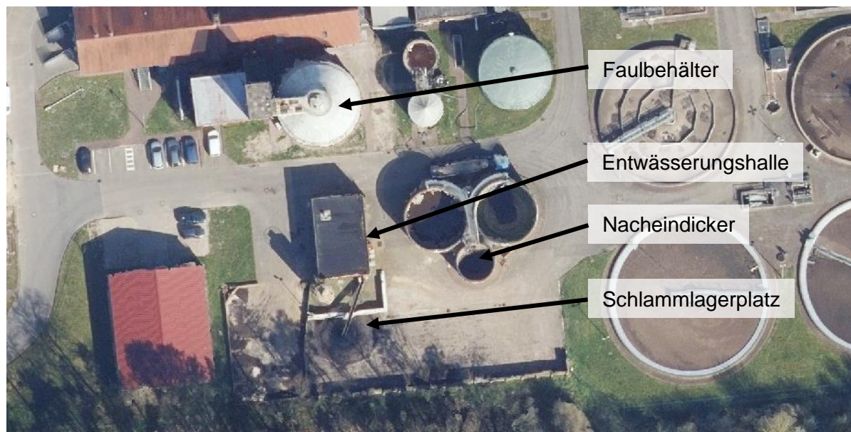
Abbildung 3: Luftbild Schlammbehandlung Kläranlage Espelkamp
