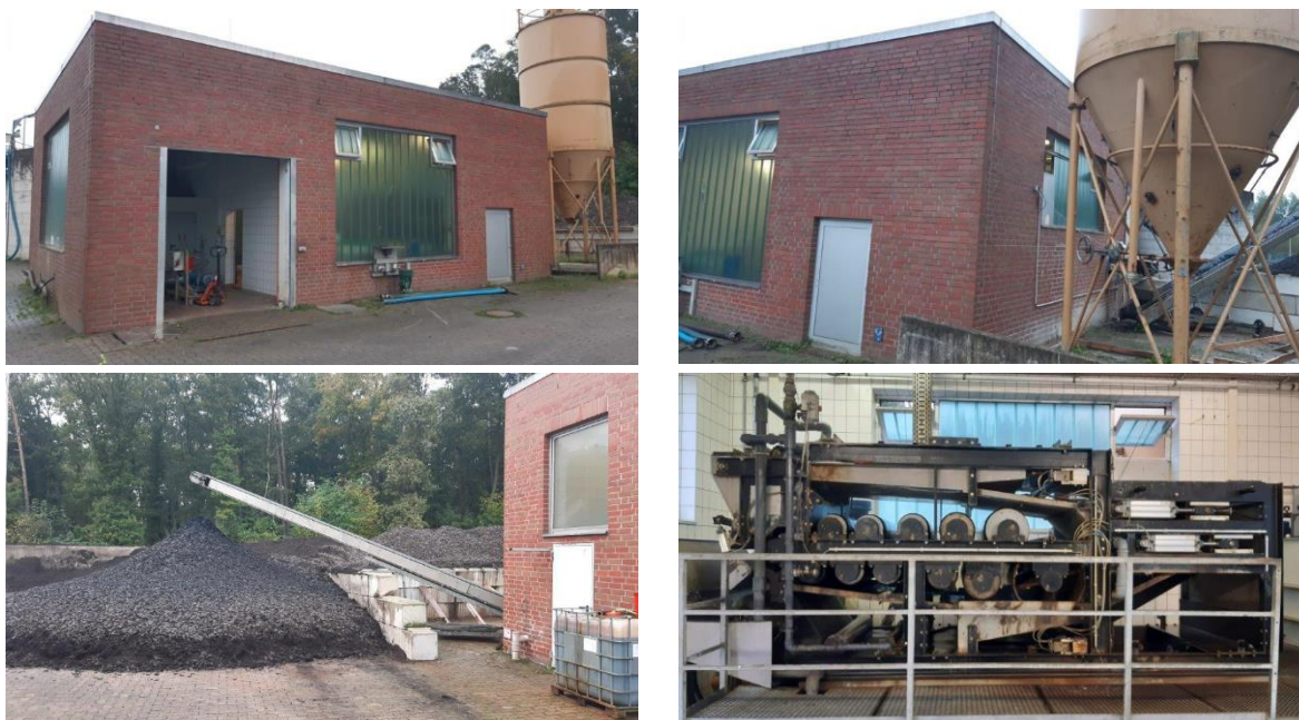
Abbildung 4: Fotos vorhandene Schlammmentwässerung
